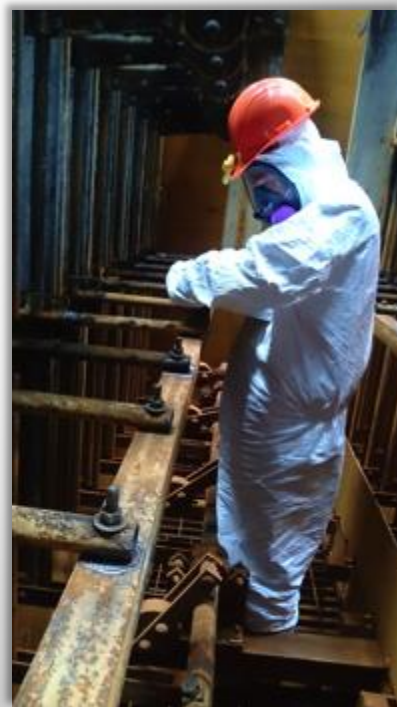
Inspección de Electrodos de Emisión
