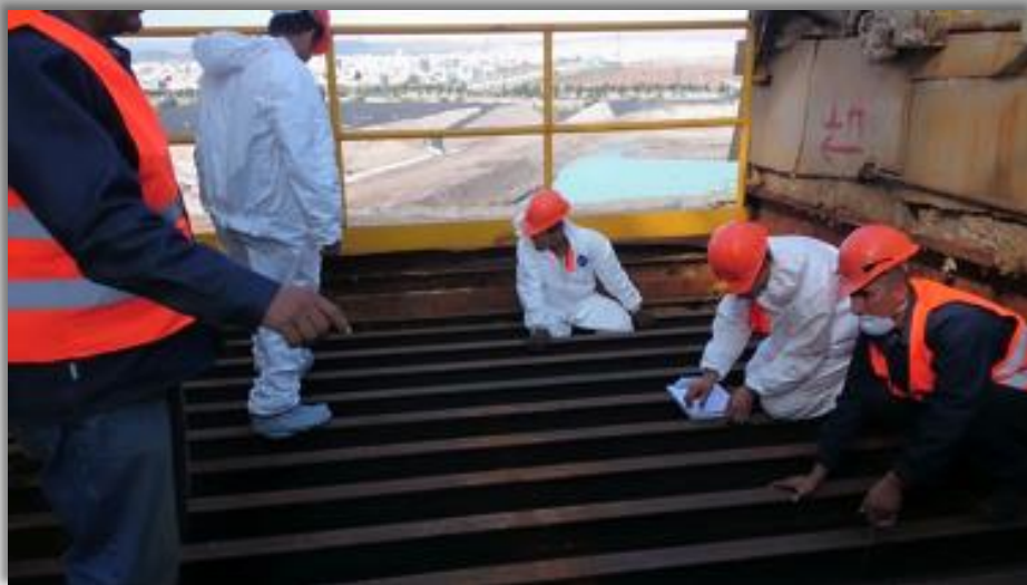
Inspección de Placas de Colección
