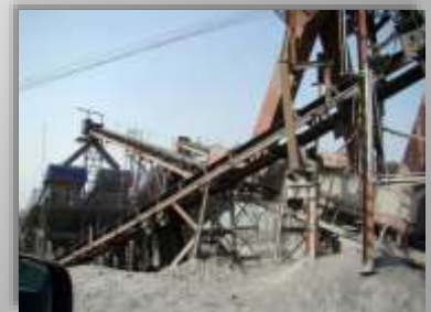
Mina con sistema de Niebla Seca en Cribas y Bandas
