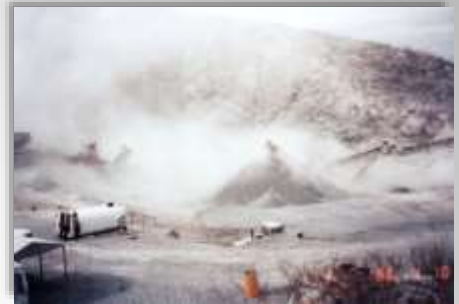
Mina antes de instalar el sistema de Niebla Seca.
