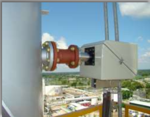
Monitor Procal 2000 instalado en PEMEX - Samaria II.
